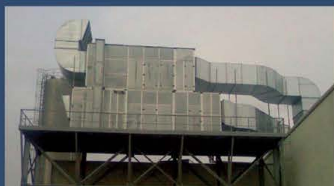
Coca&Cola, Ukraina Urządzenie klimatyzacyjne typu H/HL o wydajności około 80.000m 3 /godz.
