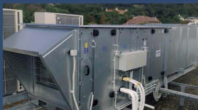
KFC Nový Smíchov Urządzenie klimatyzacyjne typu H/HL (2 jednostki) o całkowitej wydajności około 20.000m 3 /godz.
