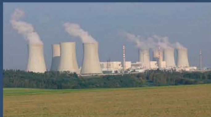
Elektrownia Atomowa Dukovany Urządzenie klimatyzacyjne typu H/HL (5 jednostek) wyprodukowanych w odpornej osłonie sejsmicznej o wydajności w zakresie 5.000-8.000m 3 /godz.
