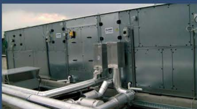
Voest Alpine Krems, Austria Urządzenie klimatyzacyjne typu H/HL o wydajności około 5.000m 3 /godz.
